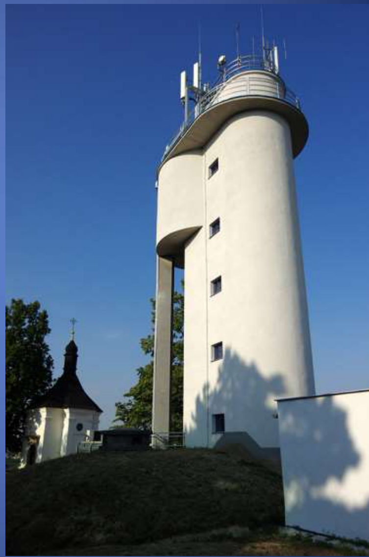
Vodojem Kostelíček Třebíč
