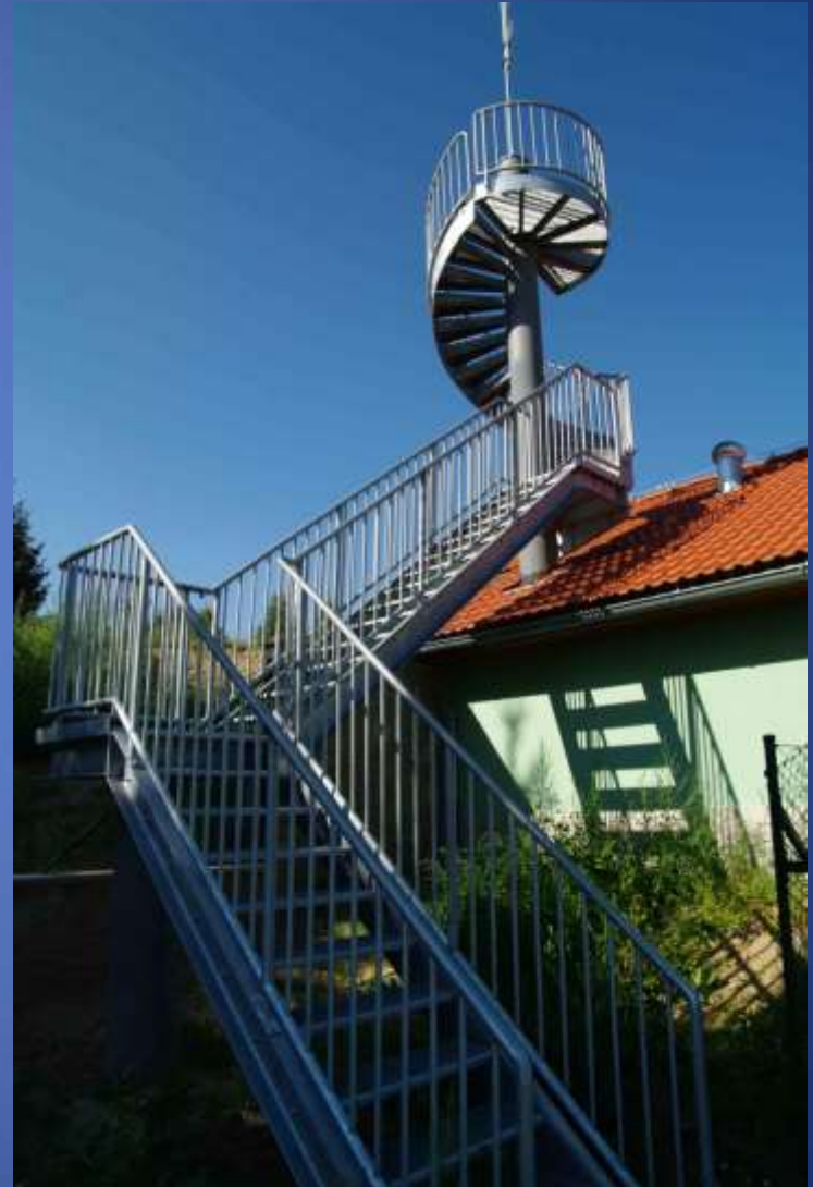
Vodojem Rubačka s rozhlednou
